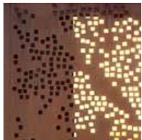
Staal perforaties voor subtiële verlichting en afwatering
